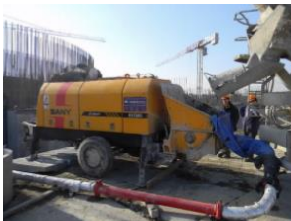
Рисунок 1. Бетоносос типа «Сани»
