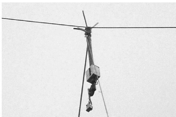
Рисунок 2 – Устройство DAC, размещенное на проводе ЛЭП
