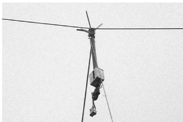
Рисунок 2 – Устройство DAC, размещенное на проводе ЛЭП
