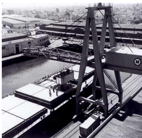
Рисунок 1 – Первый А-образный кран для обработки контейнеров
