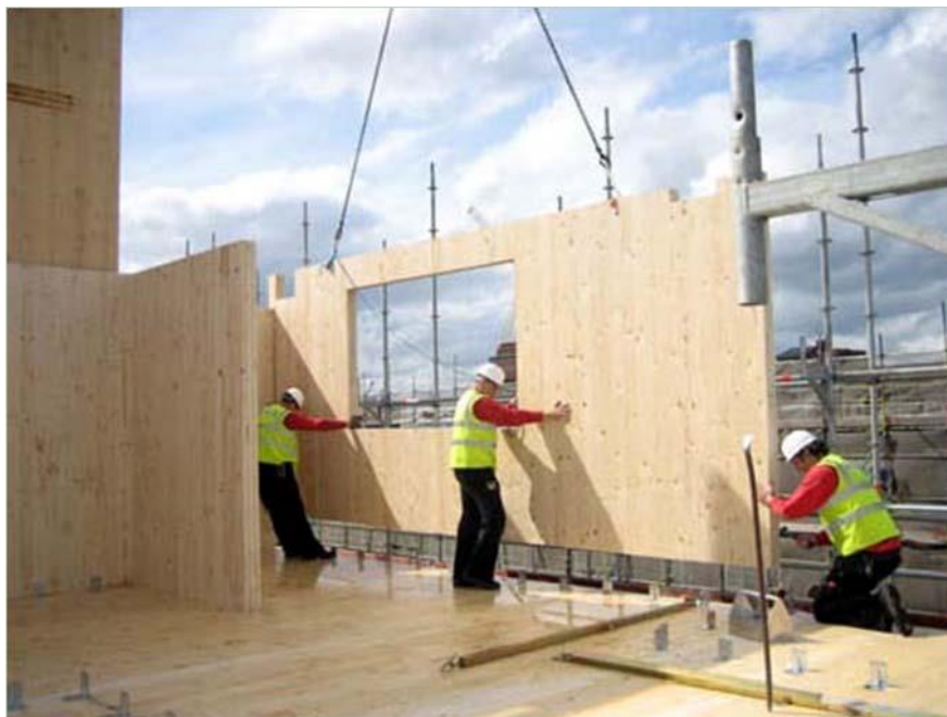
Рисунок 1. Сборка дома из clt панелей
