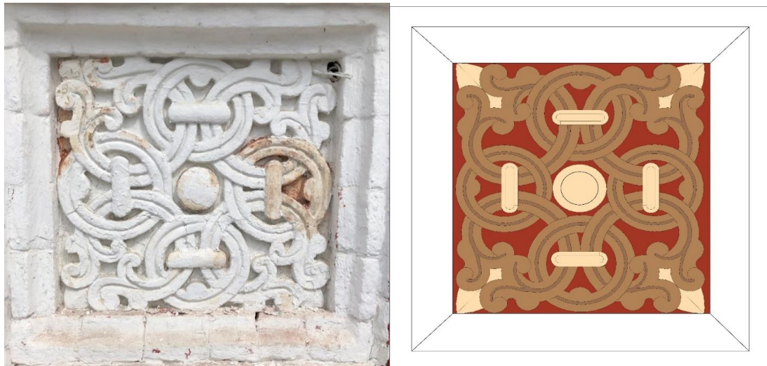
Рис. 1 (а, б) - а) Изразец главного фасада с первоначальным красным фоном и цветом слоновой кости в самом рисунке. б) Схема первоначального цветового решения изразцов первого этажа и ширинок во фризовой части драматического театра по результатам проведенных исследований
