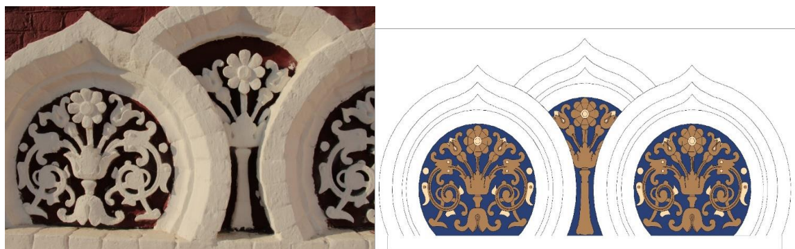
Рис. 6 (а, б) – а) Изразцы внутри кокошника в уровне третьего этажа главного фасада. Существующее состояние. б) Схема первоначального цветового решения изразца кокошника в уровне третьего этажа главного фасада по результатам проведенных исследований
