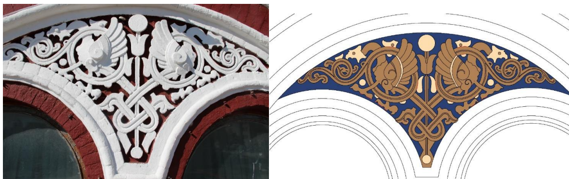
Рис. 5 (а,б) – а) Декор в поле сандрика в уровне третьего этажа главного фасада. Существующее состояние. б) Схема первоначального цветового решения декора в поле сандрика в уровне третьего этажа главного фасада по результатам проведенных исследований
