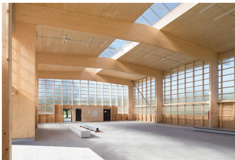
Рисунок №1. Строительство здания из CLT панелей.
